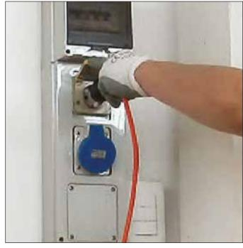
1. Das Stromkabel prüfen, ob es mit der Steckdose verbunden ist, beschädigt ist oder andere Fehler aufweist. /\*
